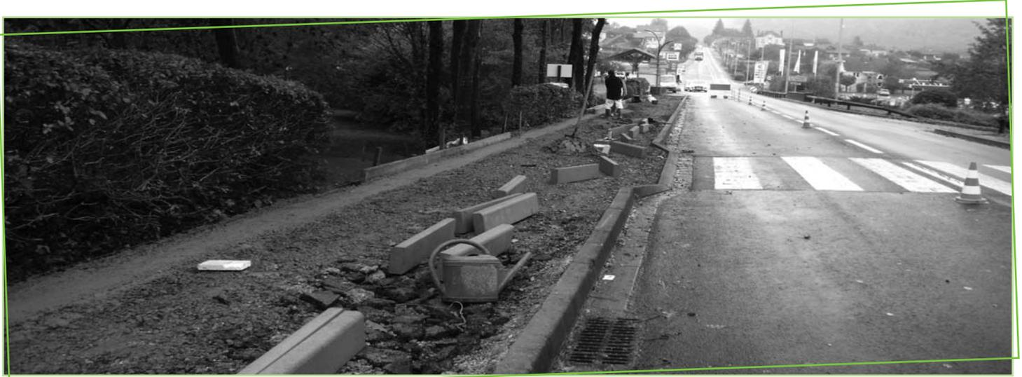
Les trottoirs d'une des principales entrées de ville, en provenance d'Aurillac, ont été entièrement refaits. Les travaux ont été réalisés par l'entreprise Caumon. Les bacs de fleurissement ont été repositionnés en bordure de talus, les trottoirs remis à niveau, avec la réalisation d'un revêtement de surface en enrobé.
