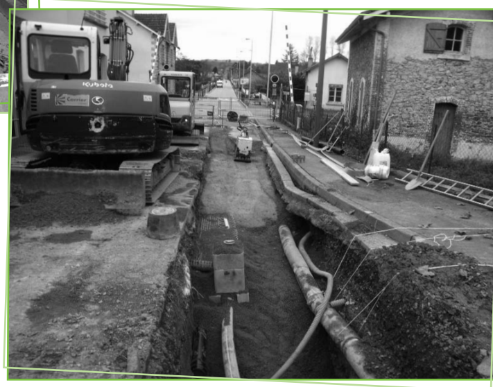
Réfection totale du réseau d'eaux pluviales et eau potable au passage à niveau.
