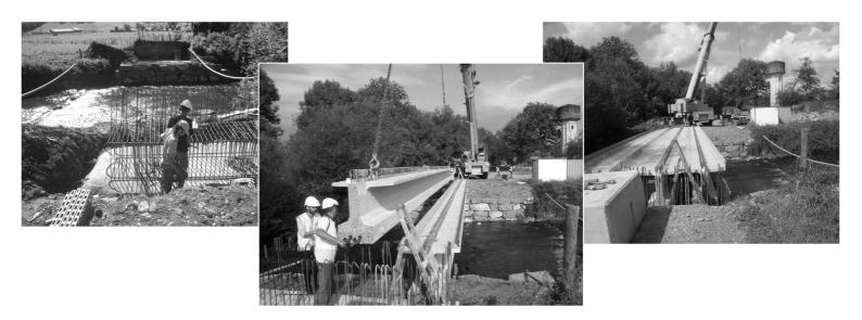
La démolition du pont est achevée, les berges ont fait l'objet d'un enrochement. La première phase de reprise des fondations pour le nouveau pont est terminée, les culées ont été bétonnées. Les quatre poutres en béton armé, d'une portée de 22 m, ont été posées le 19 septembre dernier.
