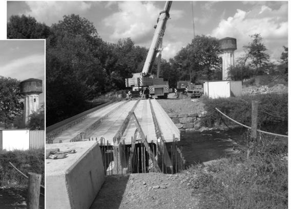
La démolition du pont est achevée, les berges ont fait l'objet d'un enrochement. La première phase de reprise des fondations pour le nouveau pont est terminée, les culées ont été bétonnées. Les quatre poutres en béton armé, d'une portée de 22 m, ont été posées le 19 septembre dernier.
